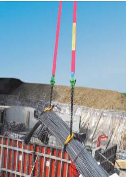
Le système de levage universel SpanSet est intéressant pour de multiples raisons; selon les besoins, il peut être retourné. La sangle est utilisée pour les charges délicates, la chaîne pour des pièces tranchantes.
