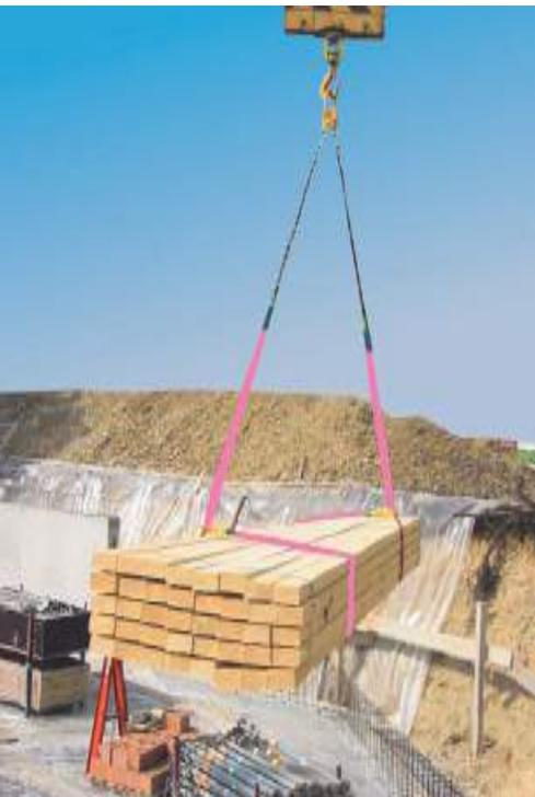
Ce système de levage pour bâtiment est équipé d'un crochet de sécurité à verrouillage automatique, grade 80.
